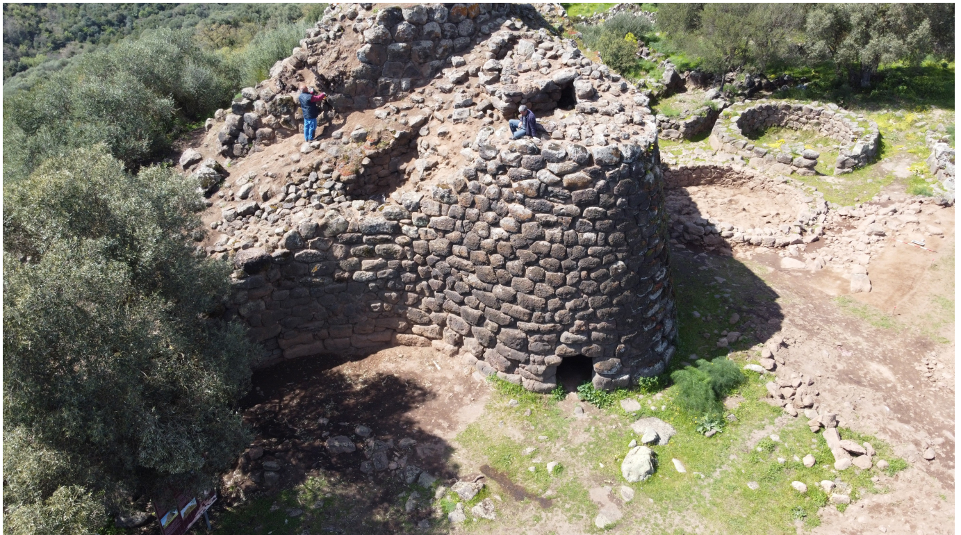
Fig. 12 Corpo trilobato del nuraghe: torre est con relativo ingresso
