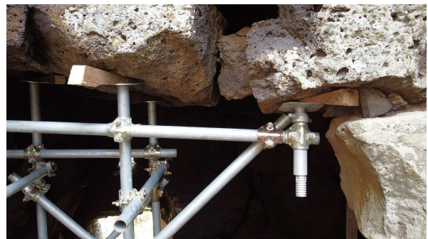
Fig. 19 - 19 Vista dall'interno verso l'ingresso e piattabanda puntellata sulla parte interna
