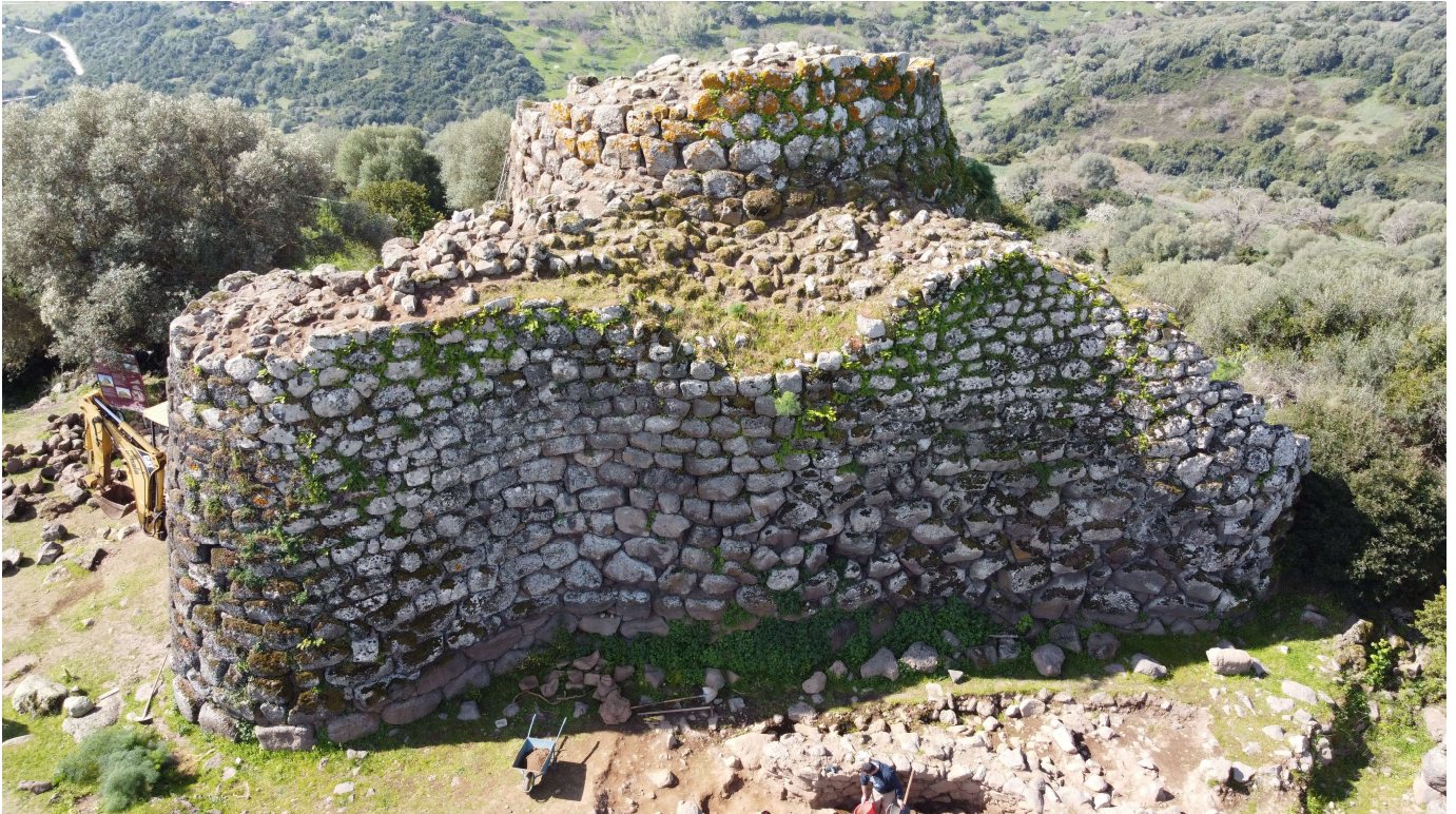
Fig. 13 Corpo trilobato del nuraghe: parete nord-est
