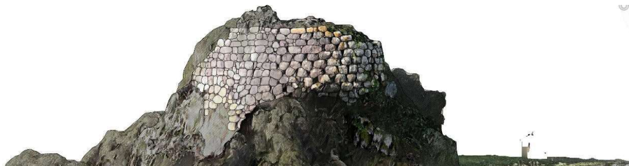
Fig. 24 Nuraghe Talasai - prospetto Est
